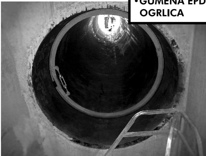
Kako PEHD i BETON imaju različito skupljanje i širenje ovisno o temperaturi tako dolazi do izljevanja „zagađene“ vode iz sustava u okolinu i zagađivanja okoline. Također na ovaj način prilikom prodiranja podzemne vode u sustav dolazi do opterećenja istog sustava.
